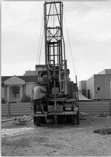
سحب عينات من التربة على اعماق مختلفة ( تبدأ من 1.5 الى 6 متر في حالة المشاريع المكونة من طابقين و يصل الى عمق 12 متر في حالة وجود طابق سرداب ) و اختبارها و ذلك لتحديد قوة تحمل التربة و اذا هناك حاجة لعمل إحلال للتربة و كذلك يوضح عمق المياه الجوفية في الأرض.
