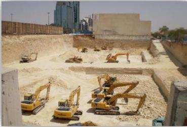
في حالة وجود سرداب يتم الحفر حتى الوصول الى منسوب المياه الجوفية ثم يستكمل الحفر بعد سحب المياه الجوفية
